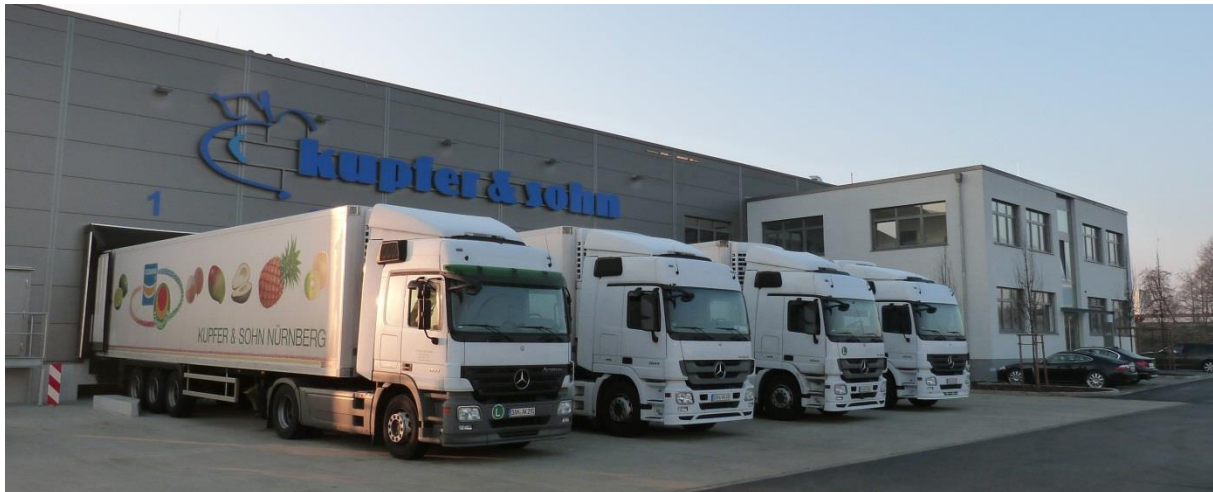
Von hier kommt die Frische zu den Kunden in Süddeutschland – Das neue Umschlaglager in Bergkirchen
